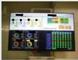
写真2-1. 現場に設置したモニター
